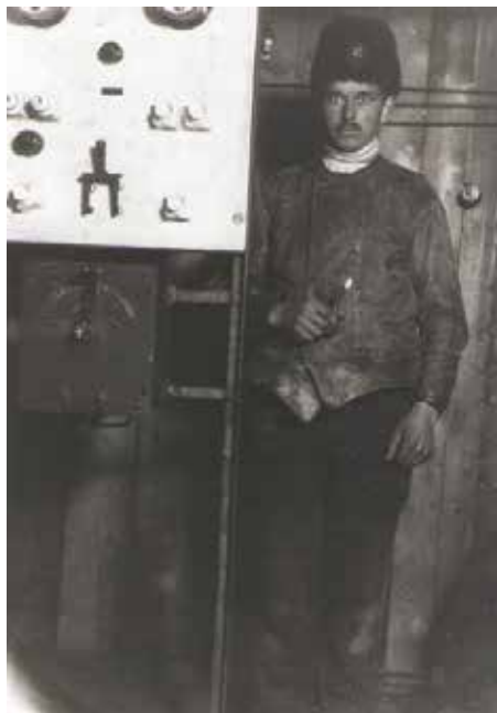
Fredrik Andersson på sin post i elektricitetsverket.
